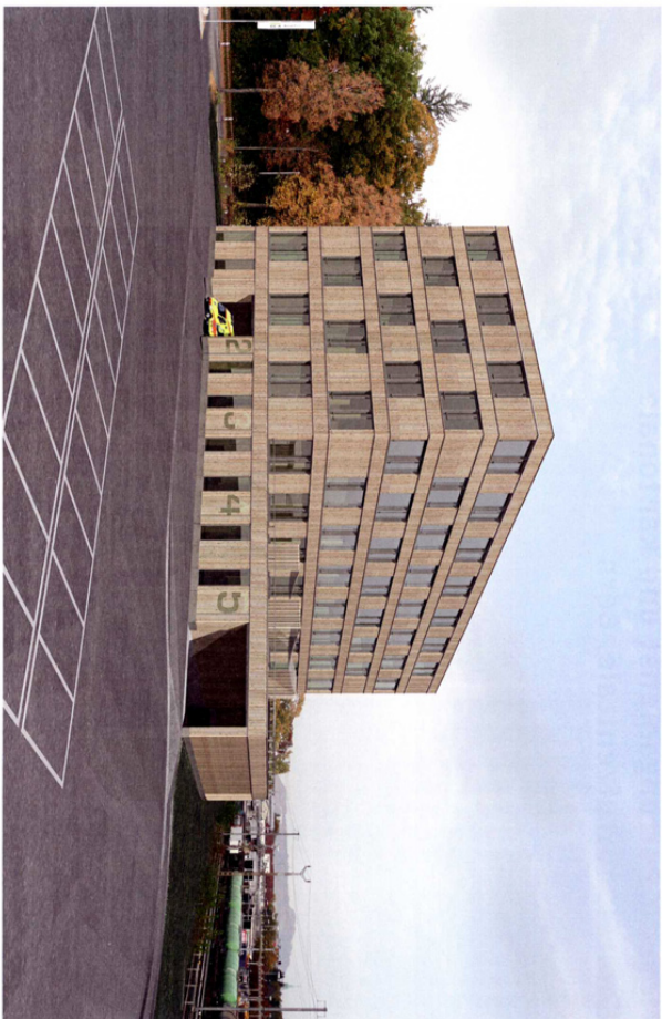
Endzustand mit den drei zusätzlich aufgesetzten Geschossen
