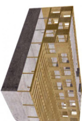
Halle, Decke und Fassade in Holz
